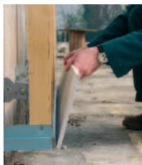
② Pose et fixation de la première rangée de clin
