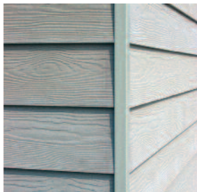
⑥ Travail terminé avec profil d'angle sortant
