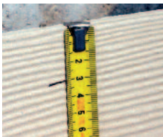
③ Recouvrement de 30 mm
