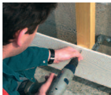
② Pose et fixation de la première rangée de clin
