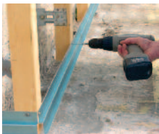
① Mise en place du profil de départ
